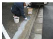
⑥コテ等でフロアパッチFCを 塗布します。 樹脂表面はコテに水をつけ 平滑に仕上げます。
