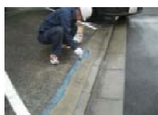
⑤湿潤面の場合は下地処理後、 湿潤面プライマーを塗布し、 連続にてフロアパッチFCの 施工に移ります。
