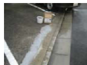
⑦気温25°Cの場合約3時間で 硬化し、歩行が可能です。
